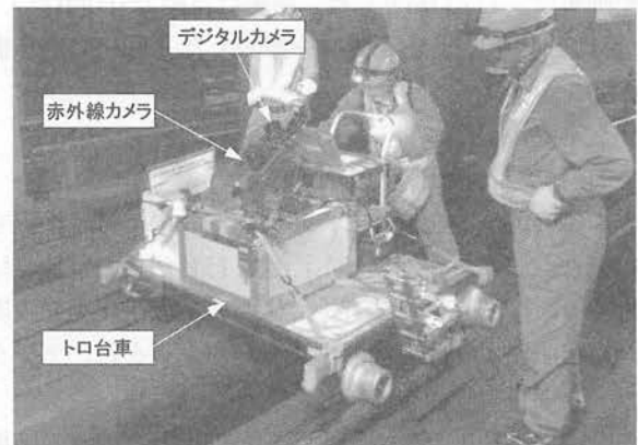
写真-1 上床版撮影状況
