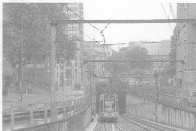
写真-4 地下区間から地上に出るトラム(エッセン)
