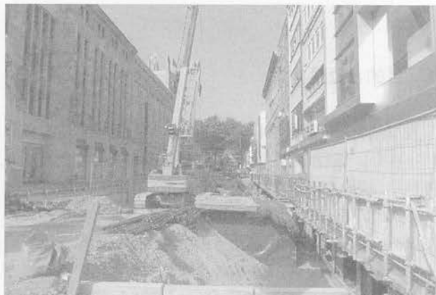
写真-5 トラムの地下化工事（カールスルーエ）
