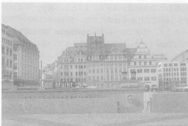
写真-3 中心市街地内に設置された新駅（ライプツィヒ）
