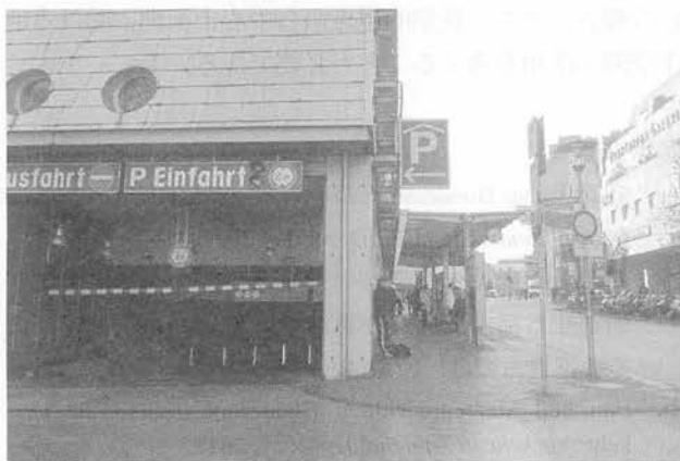
写真-16 地下駐車場出入口（カッセル）
