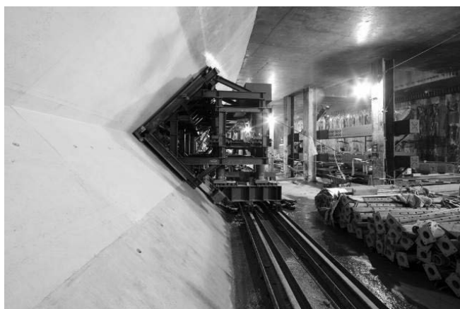
写真-2 スライディングフォームを利用した縦壁の施工
