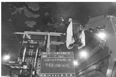
写真-4 吊り金具撤去状況
