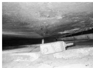
写真-1 天井板吊り材の破断
