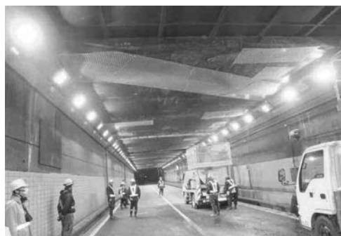
写真-6 剥落防止の施工後
