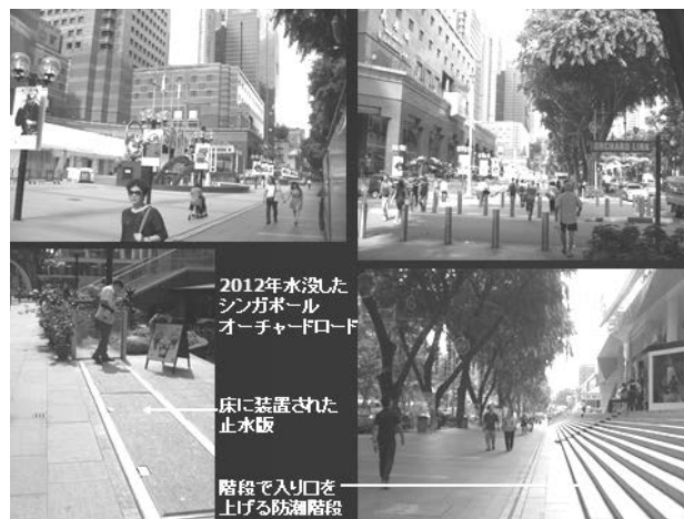
写真-9 シンガポールの止水版と嵩上げ例
