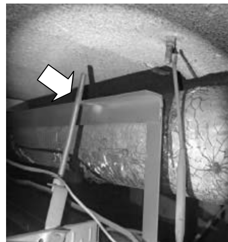
写―5 溶接による共吊り
