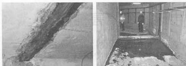
写真-1 損壊した樋と企業洞道接続部からの漏水と滞水
