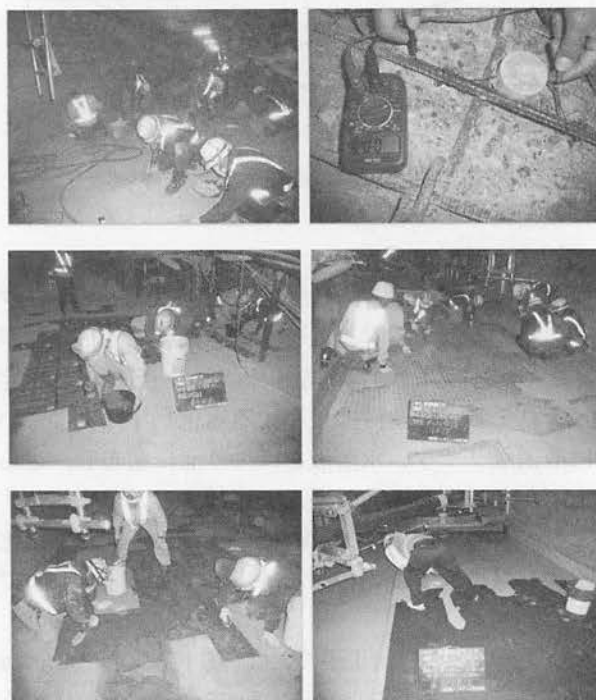
写真-5 左上：塩害損傷部はつり 右上：犠牲陽極 左中：鉄筋の防錆 右中：ステンレス網筋配置 左下：モルタルコテ塗り 右下：塗床防水材塗布
