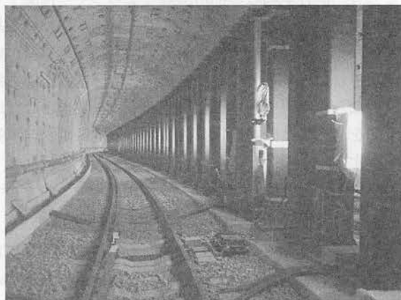
写真-1 シールドトンネル
