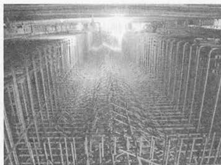
写真-1 埋設物と型枠・鉄筋組立工
