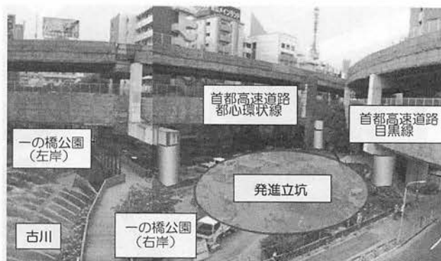
写真-2 一の橋公園状況
