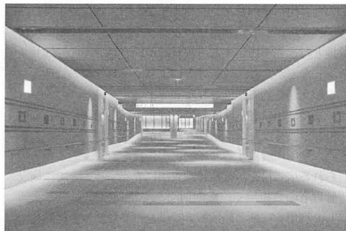
写真-4 完成した はかた駅前通り地下通路
