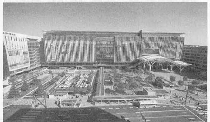
写真-2 再整備後の駅前広場（地上全景）
