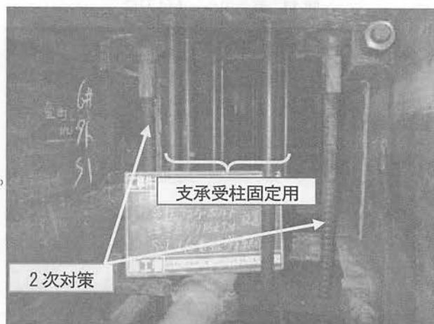
写真-1 アンカーボルト設置写真（隅角部エレメント内部）
