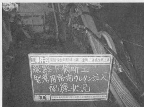
写真-2 発泡ウレタン注入ホース設置状況
