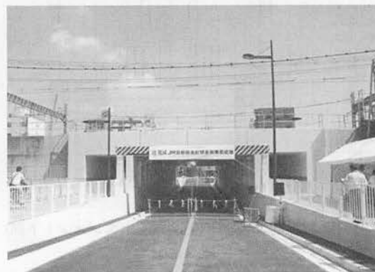
写真-3 完成写真
