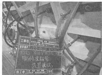
写真-3 貼付凍結管設置状況
