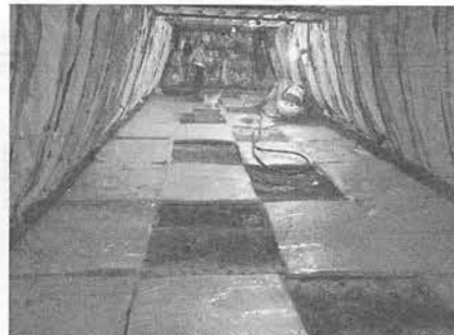
写真-6 シールドトンネル間掘削状況
