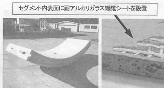
写真-2 繊維補強シートによる剥落防止対策
