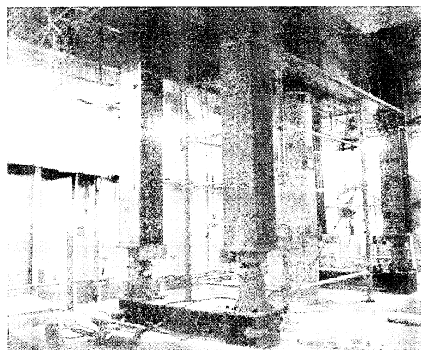
写真-1 上：A 線側地下 2 階仮受け 下：B 線側地下 2 階仮受け
