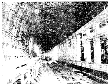
【STEP5-1】切開き完了（坑内側）
