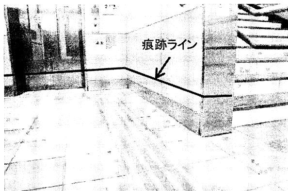
写真-1 JR高蔵寺駅構内の浸水痕跡
