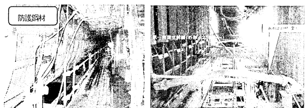
写真-10 六丁の目工区下水管状況
