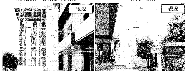
写真-9 仙台駅前建築物補修状況
