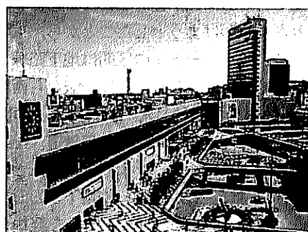
図-3 現在の仙台駅舎(西口)
