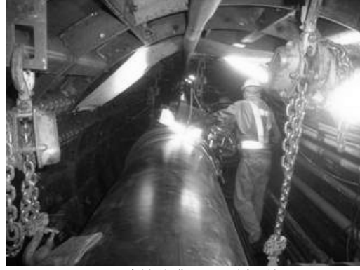
図-10 溶接作業状況（自動）
