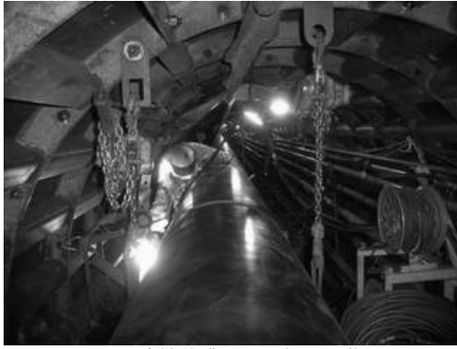
図-9 溶接作業状況（ティグ）
