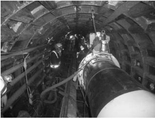
図-11 塗覆装作業状況（自動）
