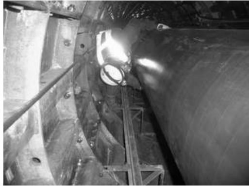
図-12 触診検査作業状況
