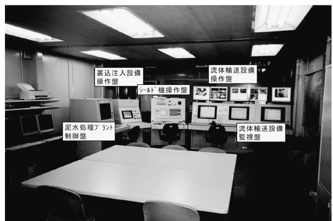
写真-1 シールド機コントロール室
