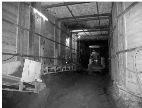
写真-3 導坑掘削状況
