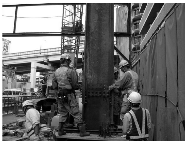
写真-7 芯材建込み状況
