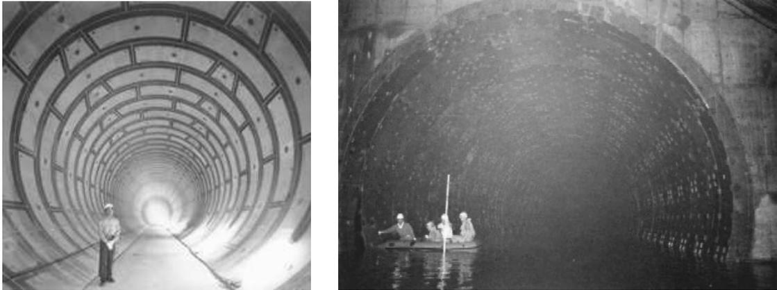
写真-4 大阪北部・南部地下河川(上:地下河川完成部分,下:貯留状況) 大阪府HP
