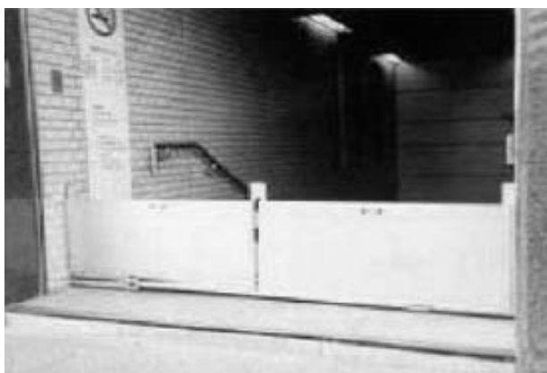
写真-2 地下出入口部の止水板の例
