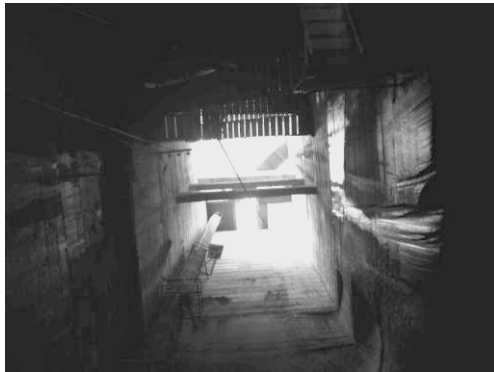
図-3 対象地下空間 B の立坑
