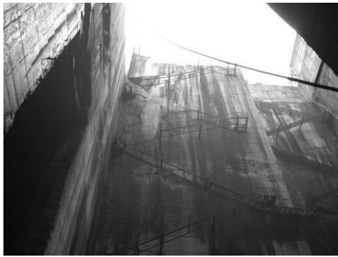
図-1 対象地下空間 A の立坑
