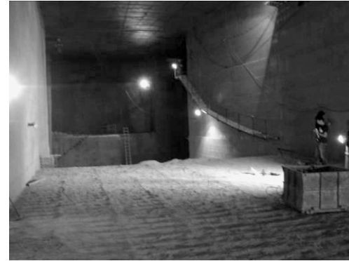
図-4 対象地下空間 B の坑道
