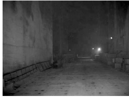
図-2 対象地下空間 A の坑道
