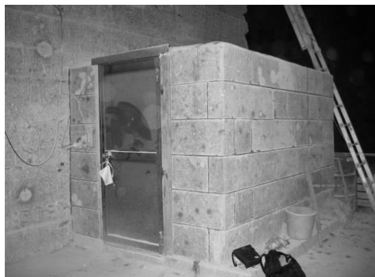
図-6 大谷地下倉庫
