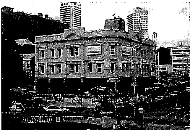
写真-3 ウェリントンビル アンダーピニング 全景
