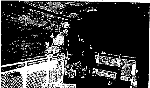
写真-1 覆工厚・背面空洞調査
