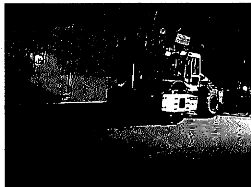
図-8 大型振動ローラーによる転圧
