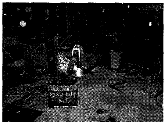
写真-5 セグメント撤去
