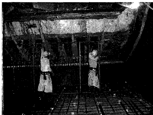
写真-4 底版配筋状況
