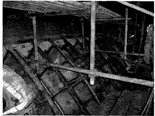
写真-1 上床梁接続部鋼製セグメント主桁
