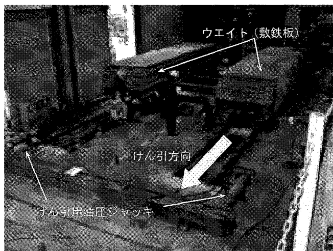
図-6 試験状況（牽引前）
