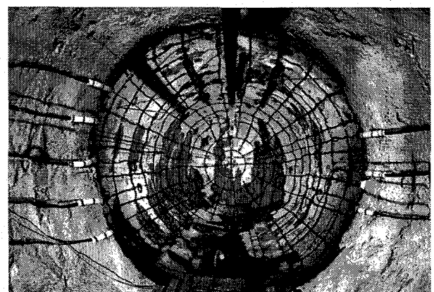
写真-3 岩盤掘削後の貯槽空洞内部（プラグ部から貯槽内部を撮影）
