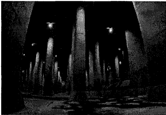
写真-4 調圧水槽
