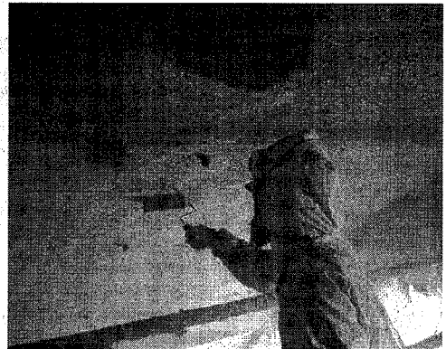
写真-3 表面仕上げ（ローラー使用）
