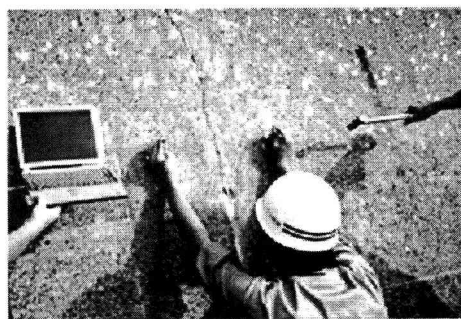
写真-1 調査状況
