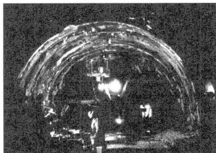
写真－5 縫返し補強工施工状況
