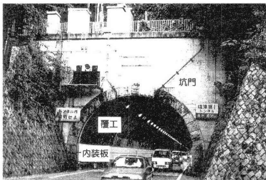
写真-7 既存トンネル本体工の現況 7)
