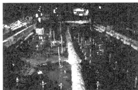
写真－6 インバート補強工施工状況
