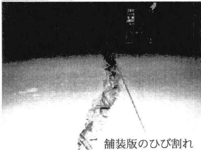
写真-1 地震による被害状況（木沢トンネル）
