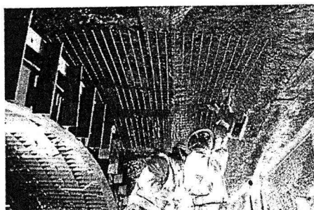
写真-3 充填前の金網取付
