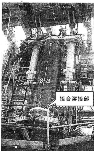
写真-4 推進状況
