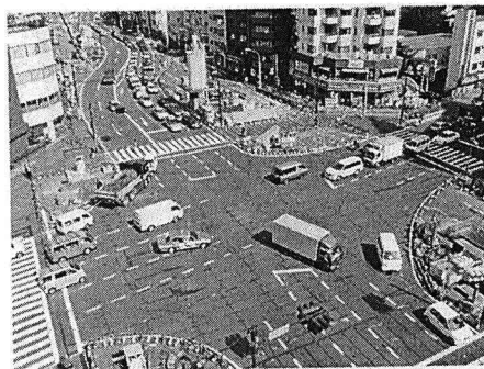
写真-4.1 施工場所全景
