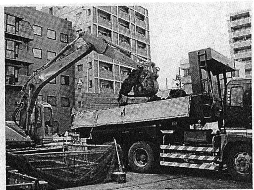
④ 普通ダンプトラックへの積み込み
