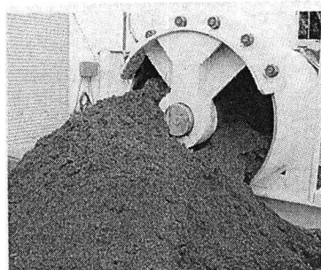
写真-3.6 改良後 処理土状況 (第3種建設発生土)
