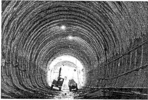
一次覆工完了状況
