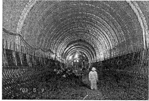
インポート鉄筋組立完了
