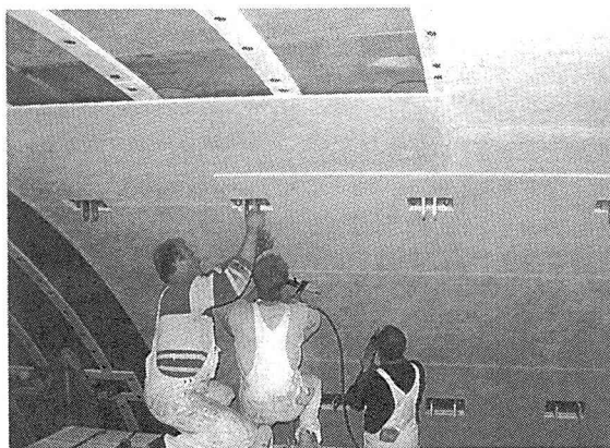
写真-3 第4エルベトンネルの施工状況
