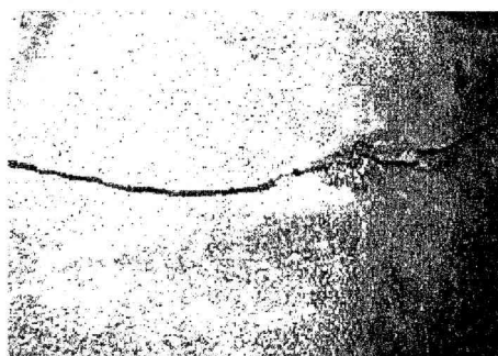
写真－1 ひび割れの一例
