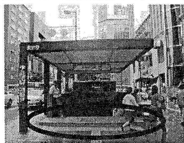
写真－1 地下街出入口の段差
