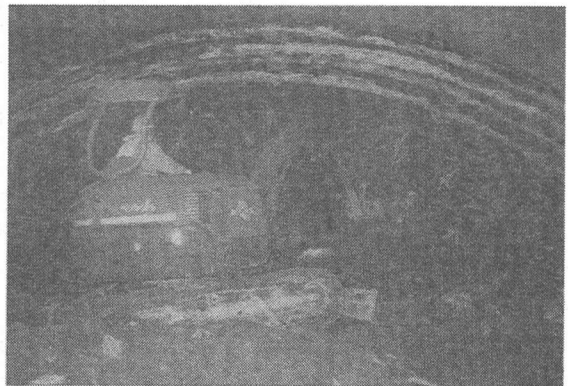
図－9 上部半断面掘削状況
