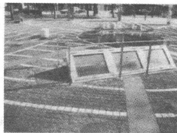
写真-5 地下に保存されているレンガ造りの下水道マンホール
