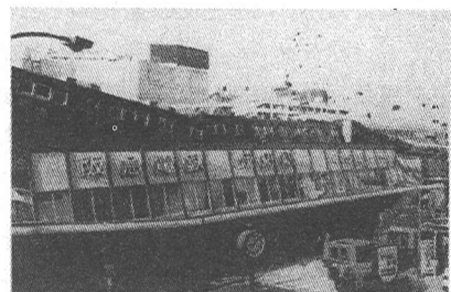
図-3 地震による地上施設の被災例
