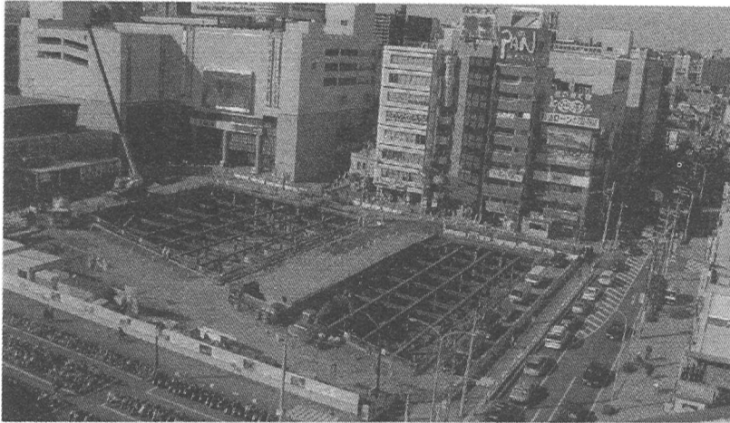
写真-3 掘削時全景
