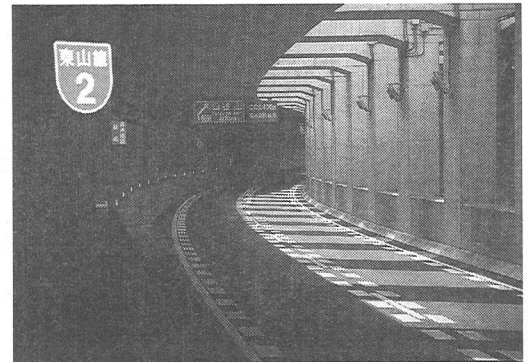
写真-2 四谷出口付近
