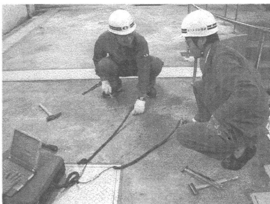
写真-2 本方法による探査状況
