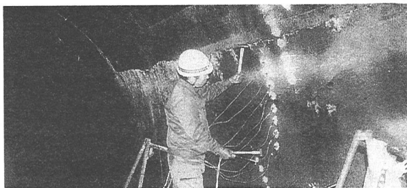
写真-2 測定状況
